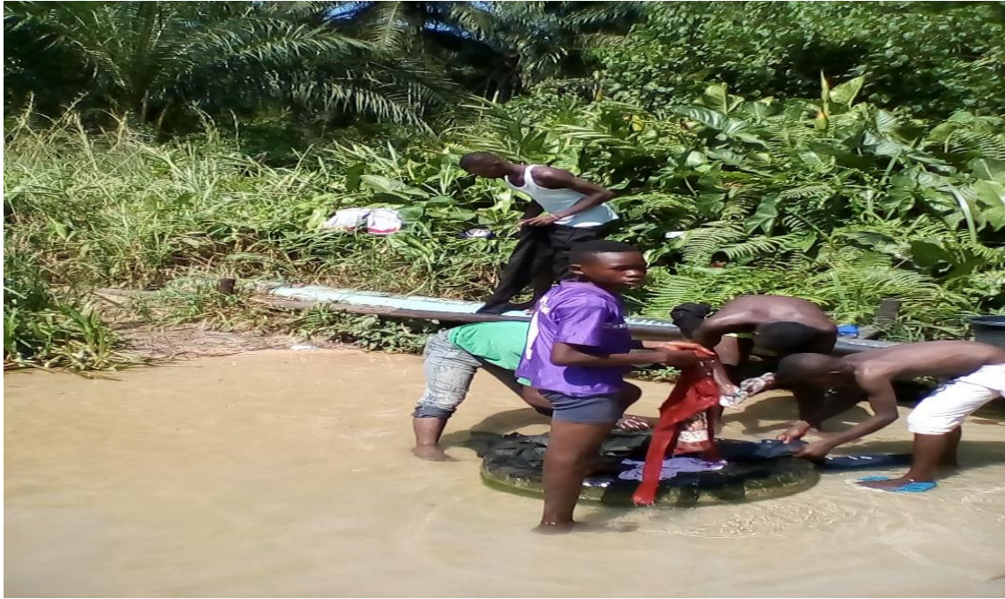
Figure 19 : Passage de pipe sans gaine de protection
